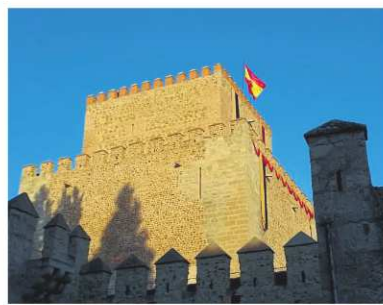
Die Burg in Ciudad Rodrigo war 1932 eine der ersten Burgen, die in einen Parador umgewandelt wurden.
